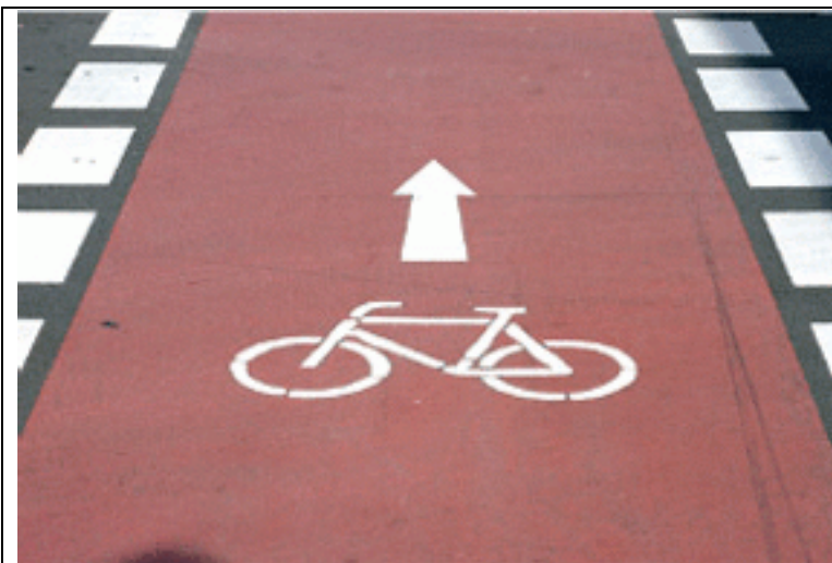
Abbildung 30: Farbige Fahrbahnmarkierungen zur Abgrenzung von Radwegen
